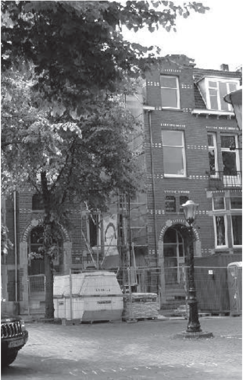
In diesem Haus im Amsterdamer Stadtzentrum (Oranje Nassau Laan 45) wohnte Recha Oettinger, Regina van Sons Schwägerin (Foto von 2005)
